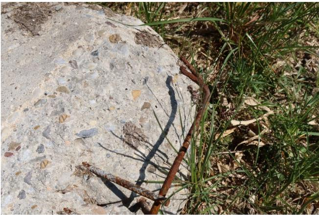
Rostige Eisenteile können Blutvergiftungen auslösen. Entfernen rostiger Teile und Sanieren der Stolperstelle sind der beste Schutz vor Verletzungen.
